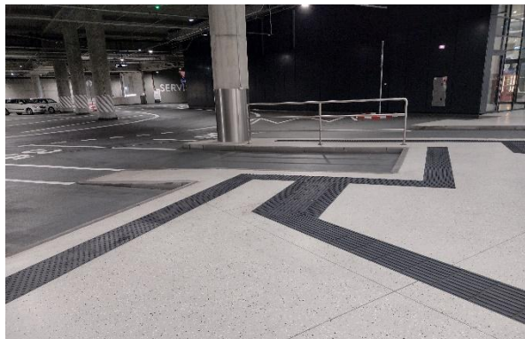
Správne umiestnený a farebne kontrastne riešený varovný a signálny pás na nástupištiach Autobusovej stanice v Bratislave.
