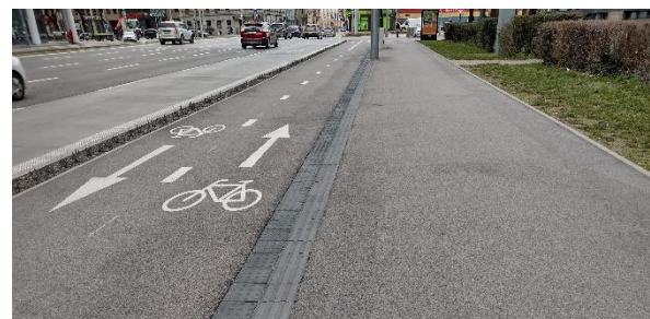
Príklad nedostatočne farebne kontrastného riešenia špeciálneho varovného pásu na rozhraní pruhu pre chodcov od pruhu pre cyklistov pri Autobusovej stanici v Bratislave.
